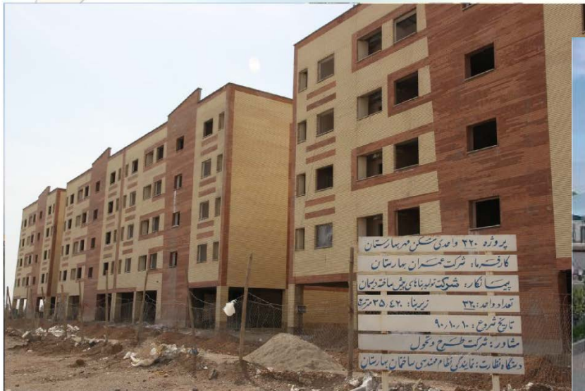
❖ تصاویر برخی پروژه‌های سیستم اسکلت بتنی پیش ساخته
